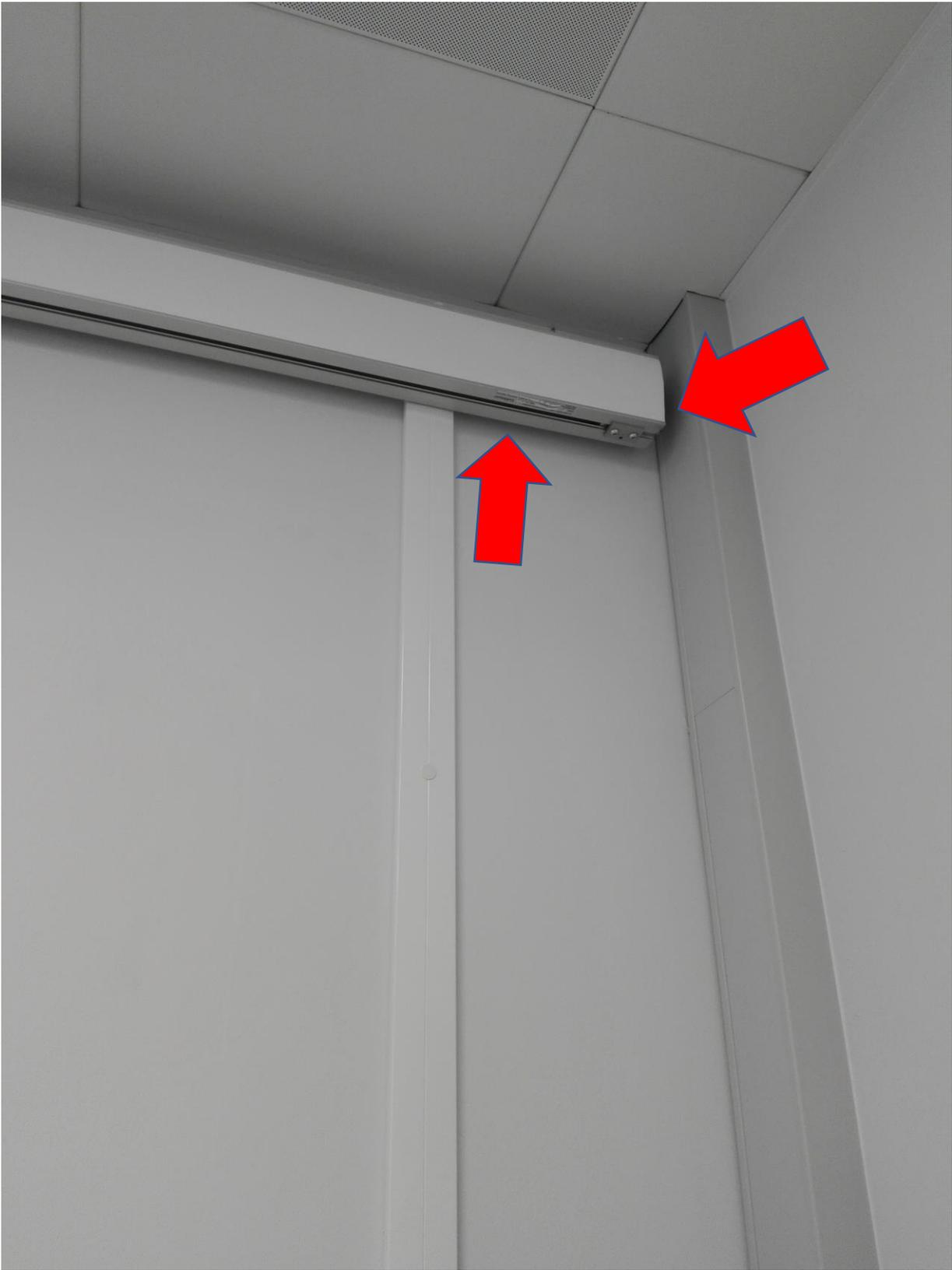
Esta misma forma de instalación podemos lograr, por una parte el riel esta fijo al muro con los soportes cortos y al mismo tiempo descarga hacia piso con soportes verticales largos.
