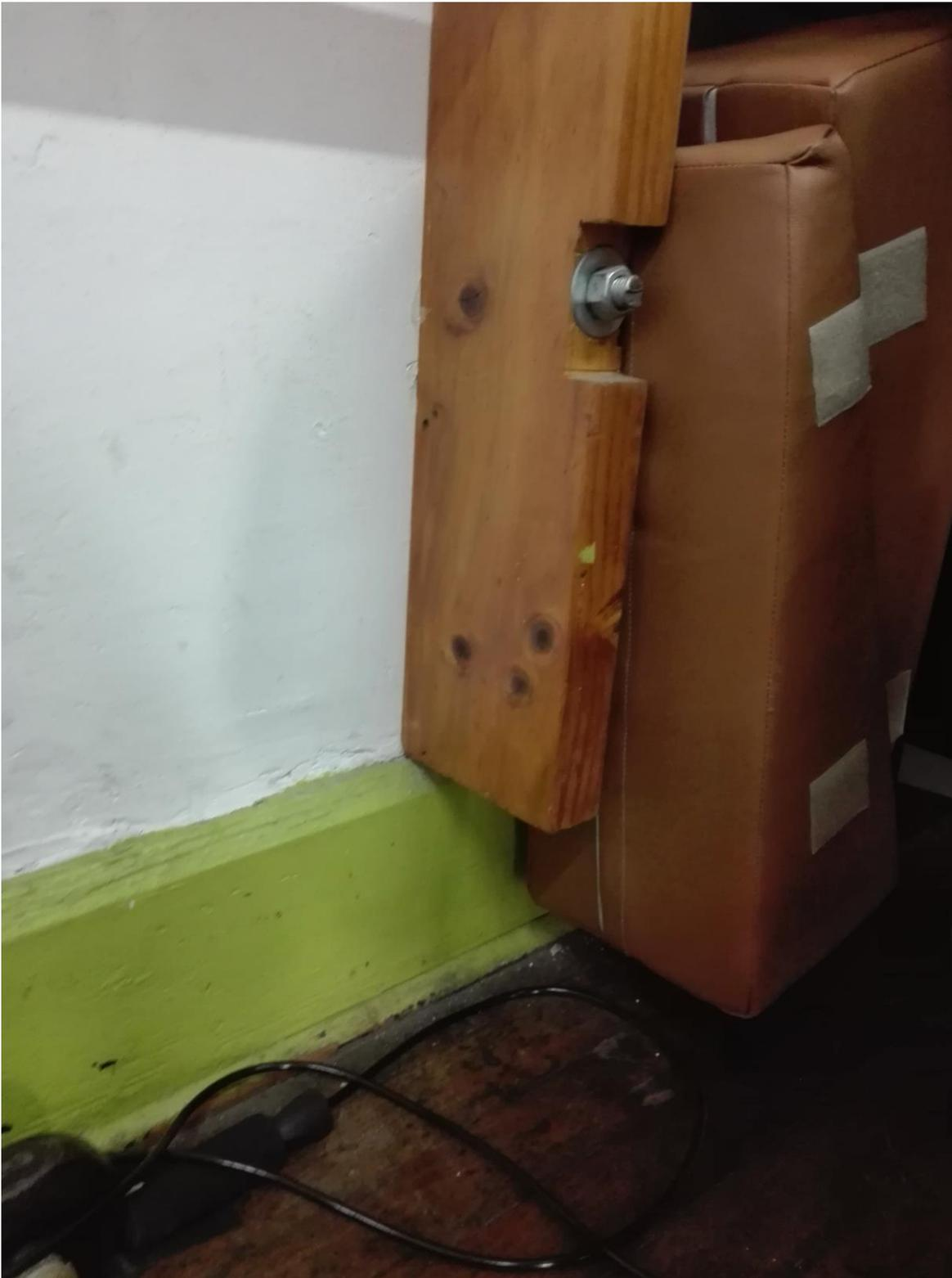
Si permiten que tapemos las ventanas, les instalamos más abajo la escalera, altura de guardapolvo 18 cms ancho 4 cms (el riel tiene 12 cms), si bajamos la escalera, tenemos el ancho para el riel.
